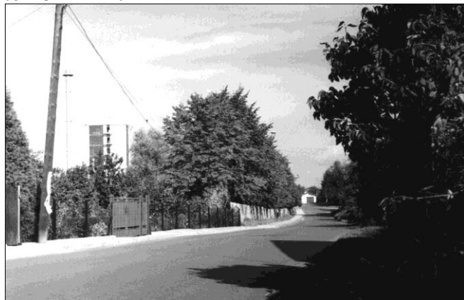
W ulicy Drożdżowej system kolektorowy został wybudowany w pierwszym roku realizacji tej inwestycji.
