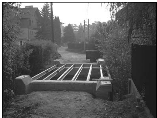
Budowa mostu na rzece Serafie w ulicy Zamłynie
