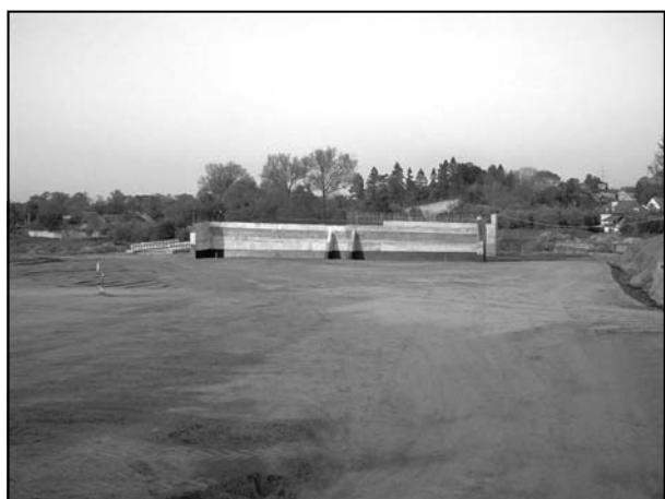
Rozmachu nabrały prace przy budowie obwodnicy autostradowej.
