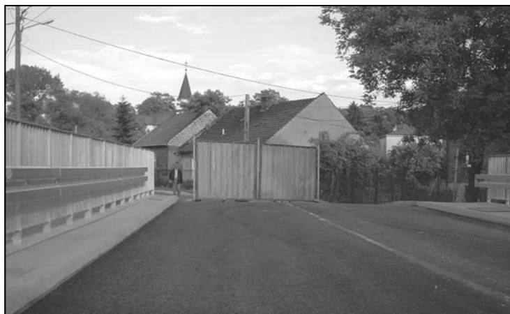
Na ulicy ks. Popiełuszki kończyła się budowa nowego mostu.
