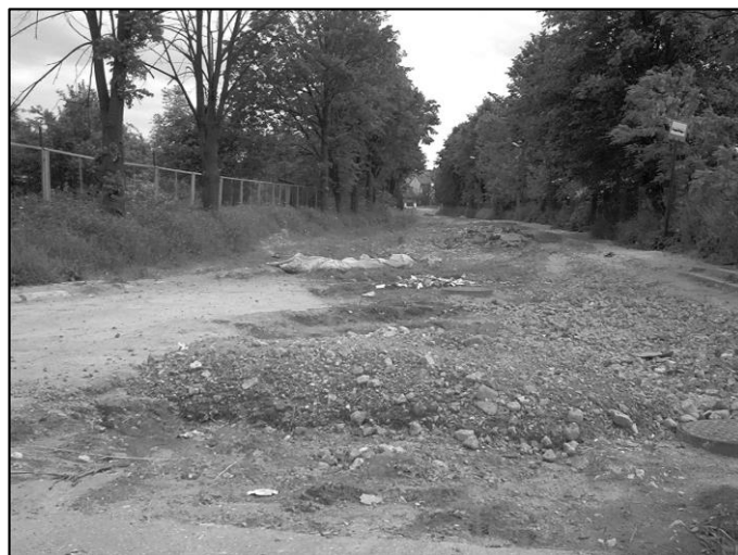
Ulica Bogucicka czeka na nową nawierzchnię
