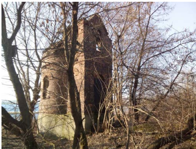
„Studnia zbiorcza” - pamiątka po historycznym Wodociągu Salinarnym z początku 20 wieku.
