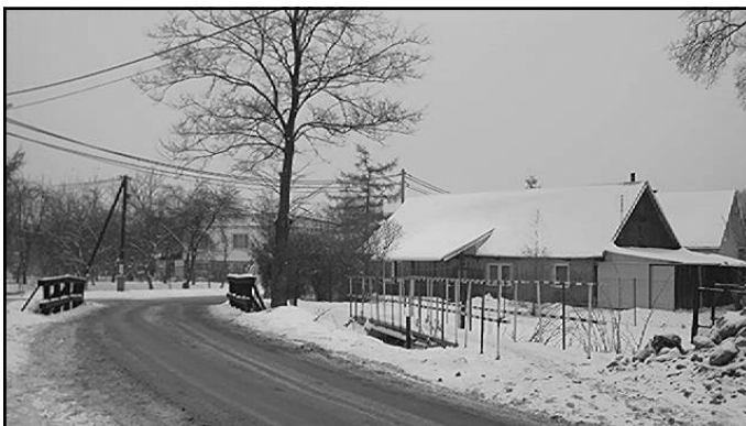
W grudniu trwały przygotowania do przebudowy mostu w ulicy ks. Popiełuszki.
